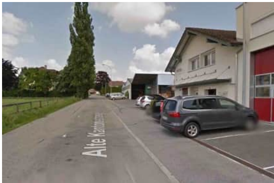
Abbildung 2 und 3: Eingeschränkte Sichtverhältnisse entlang Trottoir aufgrund direkt angrenzender Senkrechtparkplätze und Ein- / Ausfahrten der Gewerbebetriebe (links, Alte Kantonsstrasse) und markierter Fussgängerlängsstreifen (rechts, Rothlistrasse)
