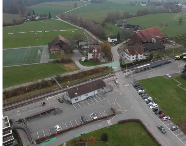
Übersicht, südlicher Teil vom Perimeter
